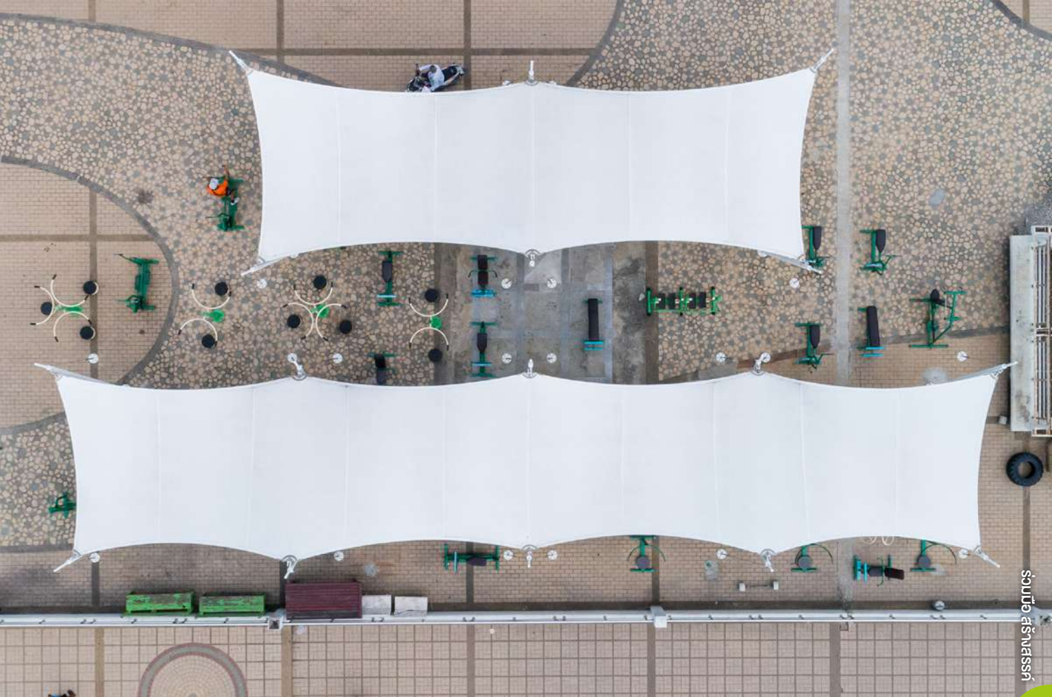
การติดตั้งเต็นท์ผ้าใบแรงดึงสูงบริเวณริมเขื่อน ถูกออกแบบให้เข้ากับสภาพแวดล้อม และประโยชน์ใช้สอย
