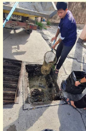
กำจัดไขมันอุดตัน ชุมชนคลองตะเคียนฝั่งตะวันตก
