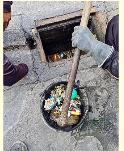
ดำเนินการเก็บดักขวดพลาสติก และเศษขยะออก และขุดลอกท่อแก้ไขปัญหาคารุดตันของท่อระบายน้ำบริเวณถนนศิริราชสุริยราช
