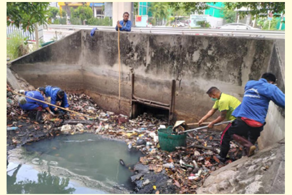
เก็บขยะและทำความสะอาดบริเวณคลองหิน คลองตาเหลือ และคลองราฟาแอล
