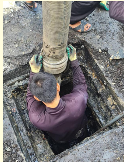
หลังการขุดเจาะ เปิดฝาท่อ ดูดล้างน้ำไขมันอุดตันออก ได้มีการให้คำแนะนำร้านค้าในการจัดทำบ่อดักไขมัน
