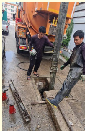
ขุดลอกท่อระบายน้ำ บริเวณถนนท้ายบ้านซอย 17
