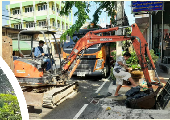
ขุดลอกท่อระบายน้ำบริเวณถนนจ๊กกะพาก แก้ไขปัญหาน้ำท่วมขัง
