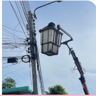
ตรวจสอบไฟถนนสุขุมวิท ซอย 37 (ซอยเพิ่มเติม)
